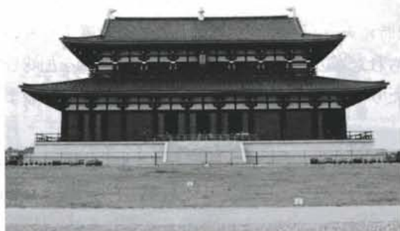
図17 完成した第一次大極殿
