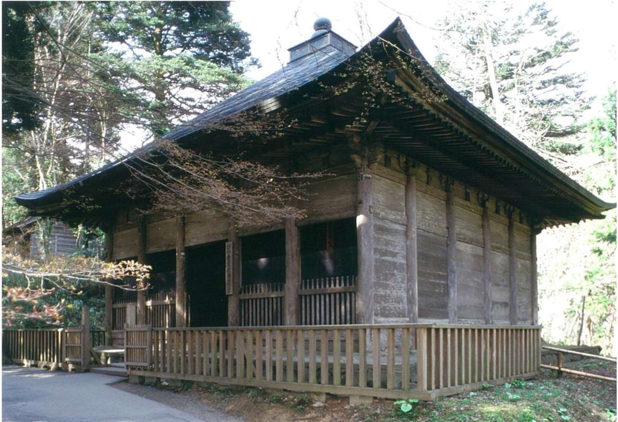
写真－２ 金色堂覆堂
